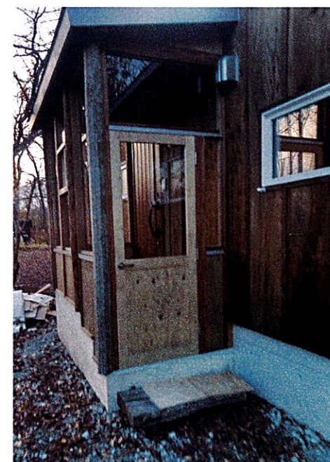
▲枠組み施工中。コンテナ本体と風除室の材料を統一することでデザインに一体感が生まれます
