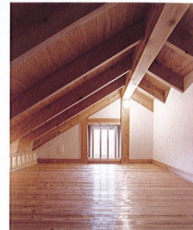
隠れ家的なロフトにも質感のよい浮造りフローリングを採用
